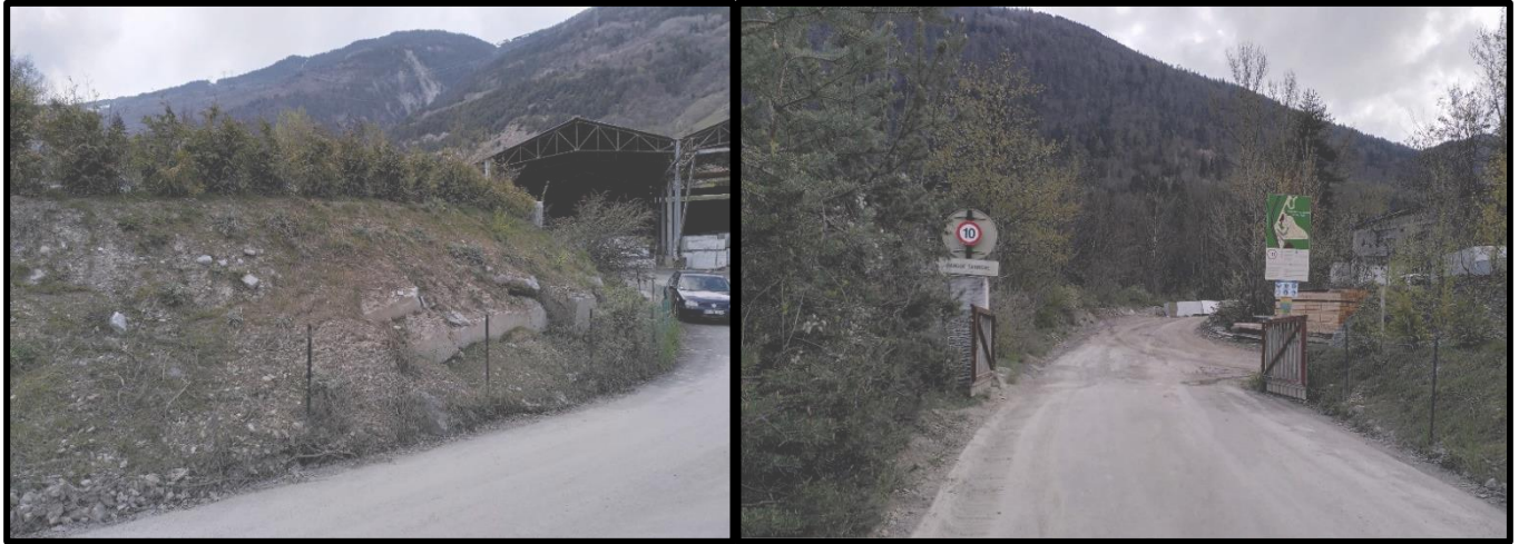
FIGURE 86 : PHOTOGRAPHIES DU MERLON CLOTURE NORD ET DU PORTAIL
