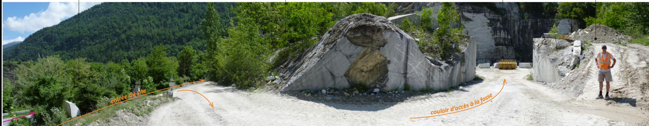
Vue 7 - Chicane entre l'entrée du site et le couloir d'accès à la fosse
