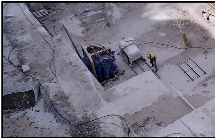
FIGURE 3 : PHOTOGRAPHIE DE LA HAVEUSE (A GAUCHE) ET DE LA SCIE A FIL DIAMANTE (A DROITE)
