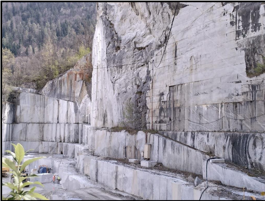
FIGURE 90 : PHOTOGRAPHIE DE LA PAROI ROCHEUSE CLOUTEE
